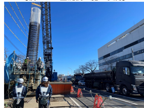
【橋りょう基礎杭の施工状況】
