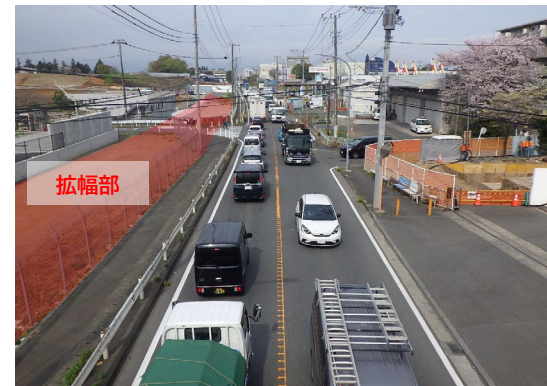
【①上川井IC付近の施工状況】
