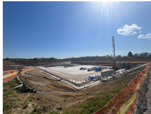
【②相沢川調整池 (地下式) の工事】
