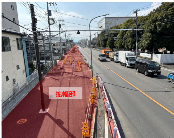
【②目黒交番前交差点付近の施工状況】
