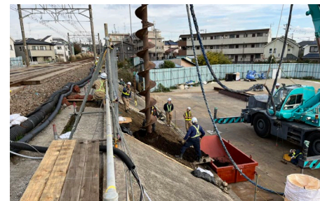
【①土留杭の施工状況】
