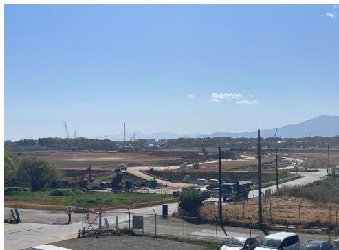
【②2号線・上下水道の整備】
