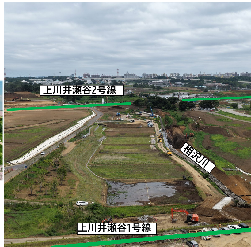
〈①相沢川周辺の工事状況〉
