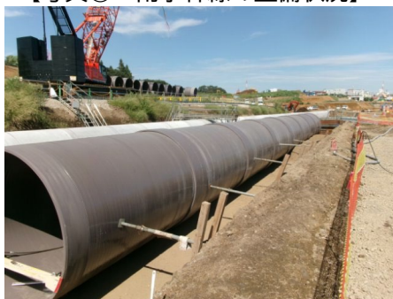
【写真①：雨水幹線の整備状況】
