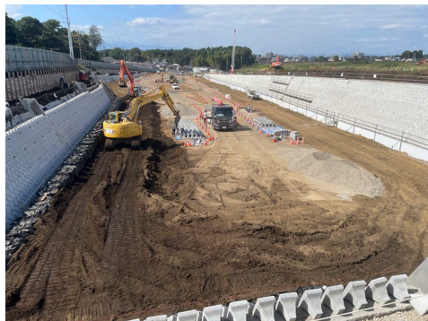
【写真①：大門川調整池の壁面工事】
