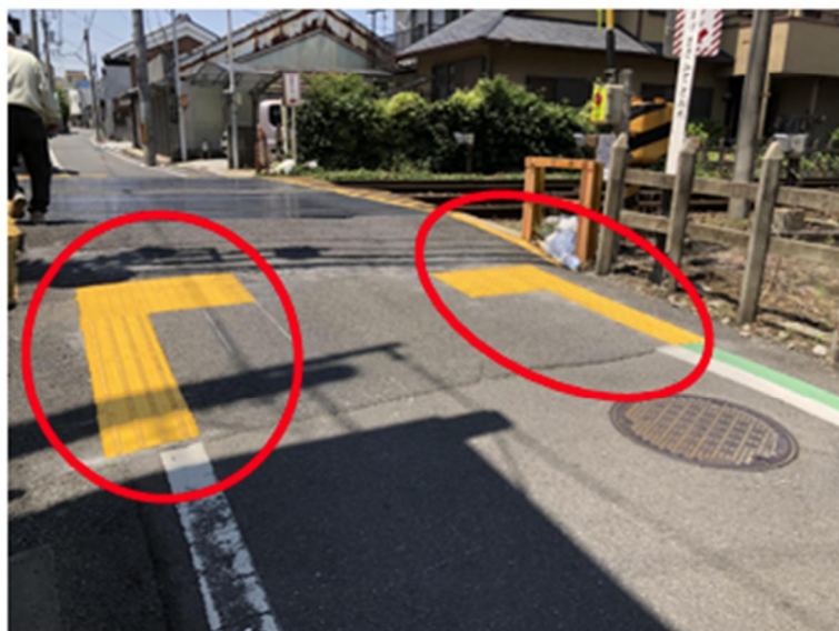
写真 2-7-16 視覚障害者誘導用ブロックを車道上に設置した事例 （令和6年1月の本ガイドライン改定前に設置した事例）
