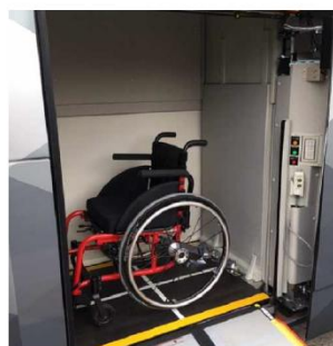
エレベーター上昇前
