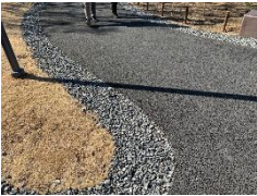
透水性 アスファルト舗装 (イメージ)
